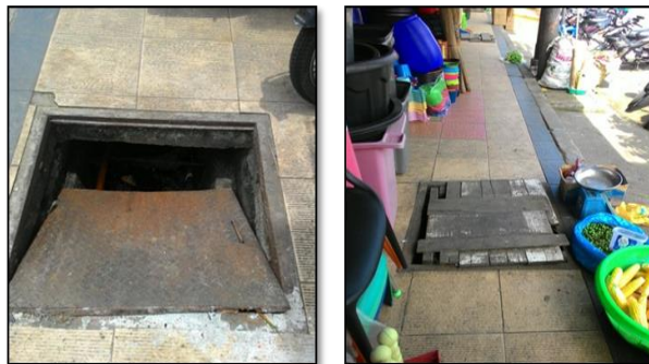
Gambar 5. Kondisi Inlet Jalur Pedestrian WR. Supratman
