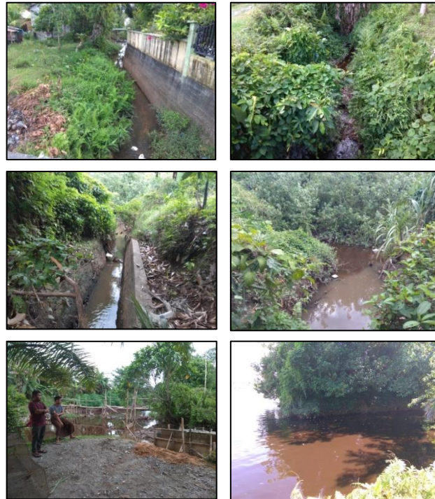
Gambar 10. Kondisi jaringan drainase existing
