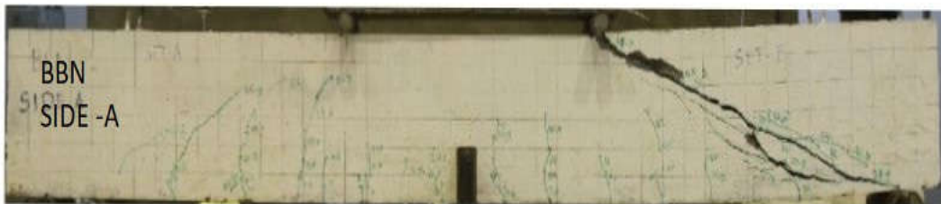
Gambar 5. Pola Retak Balok Beton Normal
