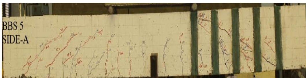
Gambar 7. Pola Retak Balok Beton Serat 5 cm
