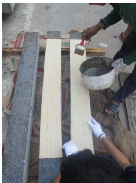
Gambar 4 Penempelan FRP serat sisal pada benda uji balok beton bertulang Sumber : Yinh (2021)
