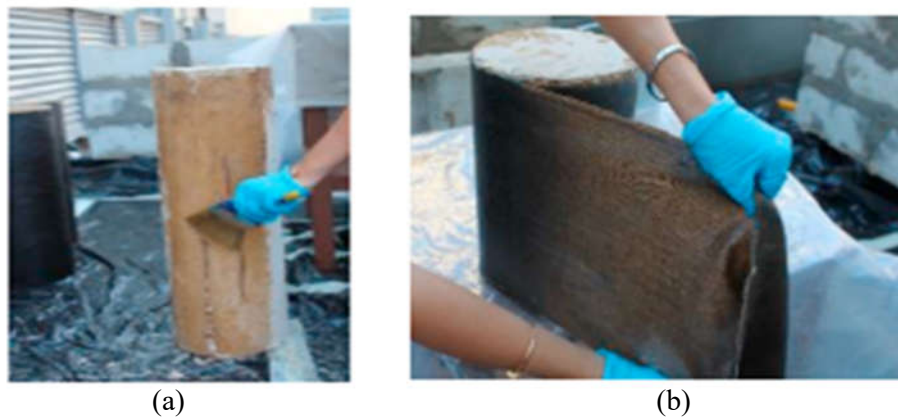
Gambar 5. (a) Persiapan permukaan beton dan (b) Proses pembalutan serat rami Sumber : Ghalieh, dkk (2017)
