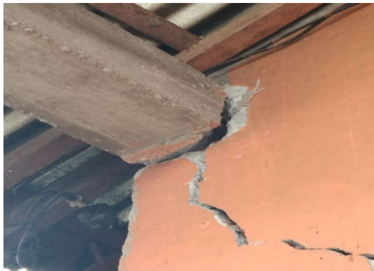
Gambar 11. Pertemuan balok dan kolom praktis.
