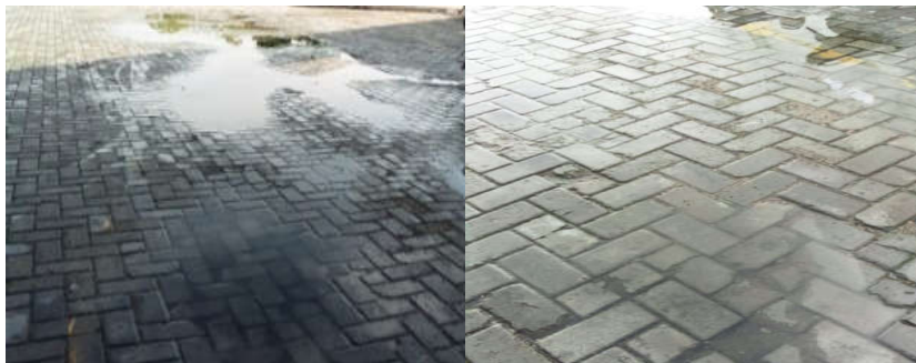
Gambar 1. Genangan air pada area parkir (Sumber dokumentasi penulis, 2023)
