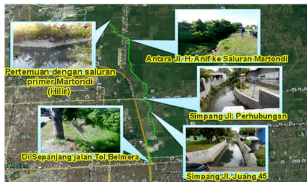
Gambar 4. Drainase Primer Tol Bandar
