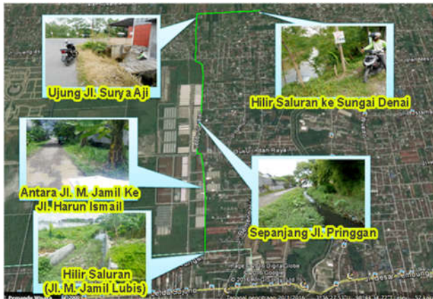
Gambar 1. Drainase Primer Kompleks TVRI
