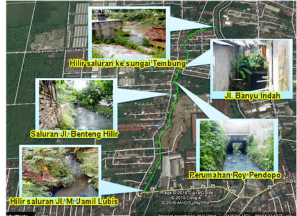
Gambar 2. Drainase Primer Titi Sewa
