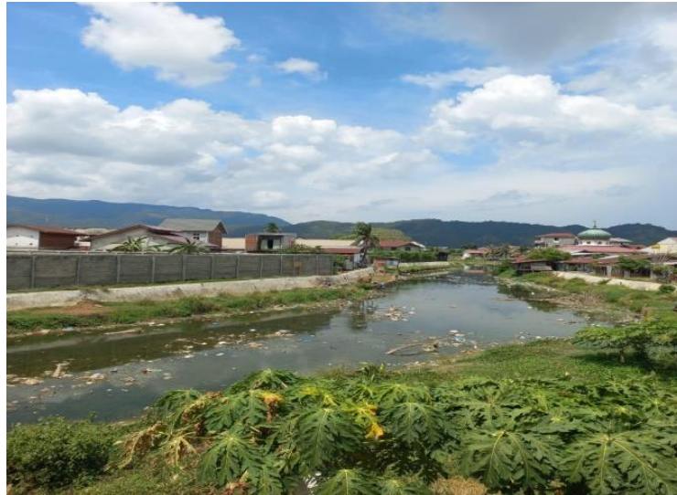
Gambar 2. Kondisi Krueng Daroy
