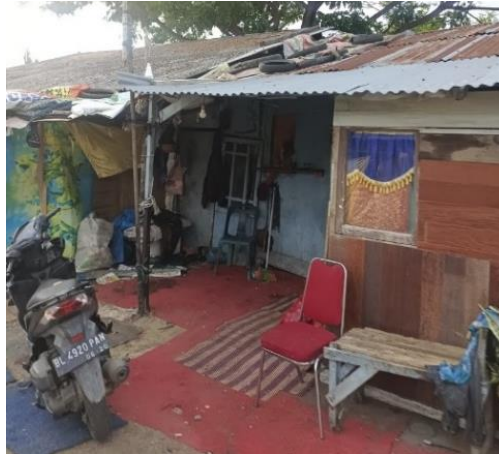
Gambar 4. Kondisi fisik bangunan di permukiman kumuh
