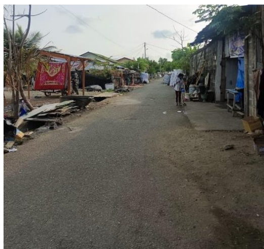
Gambar 5. kondisi fisik jalan di kawasan kumuh Gampong Jawa
