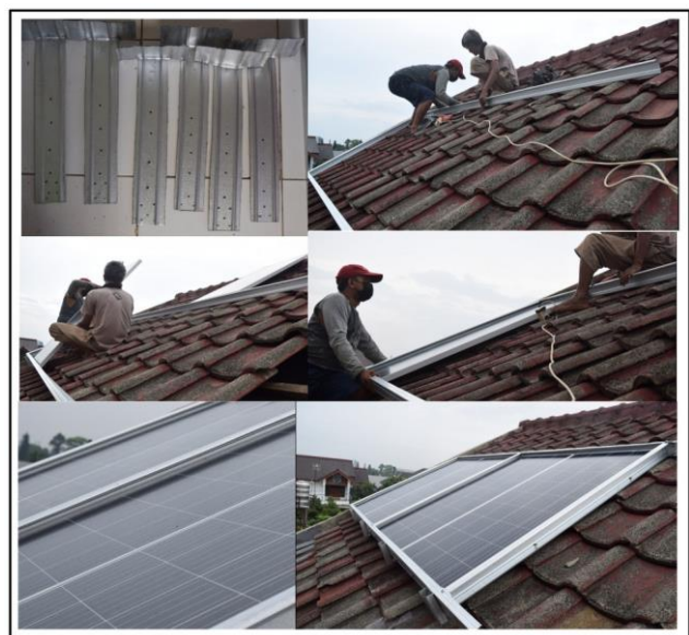
Gambar 5. Pemasangan solar panel di atap rumah
