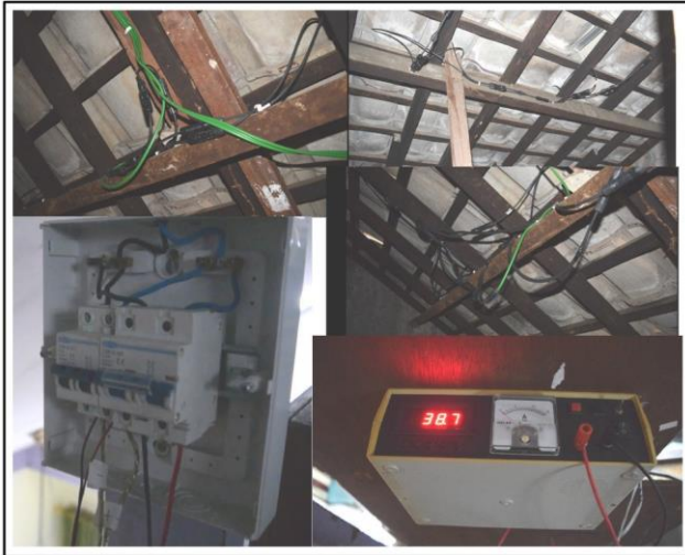
Gambar 6. Pemasangan kabel solar panel
