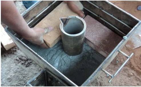
Gambar 5. Pemasangan Batu Tahan Api
