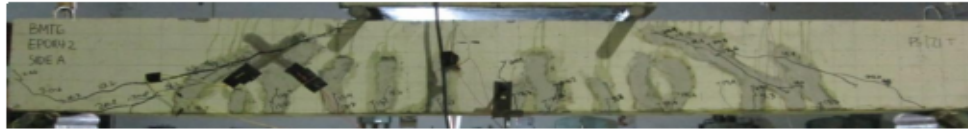
Foto Pola Retak BBMTG E-7 Setelah di Epoxy
