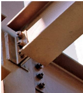
Gambar 1. Shear Lag pada Sambungan profil WF
