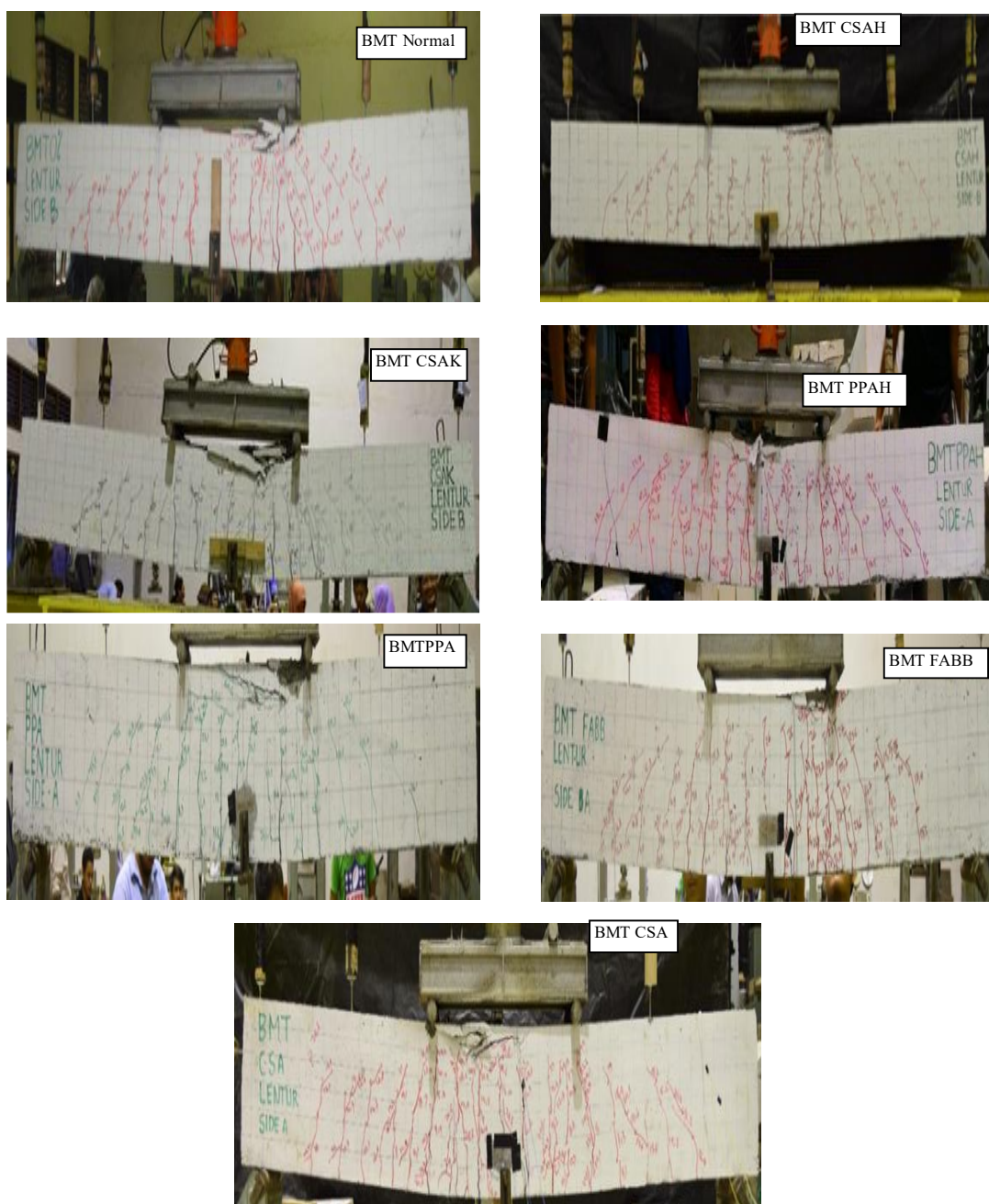
Gambar 13. Pola Retak Balok BMT dengan Variasi Aditif dan Substitusi Agregat
