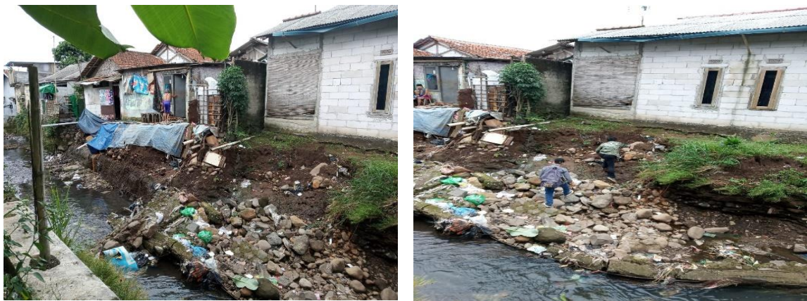
Gambar 2. Kondisi Eksisting Dinding Penahan Tanah
