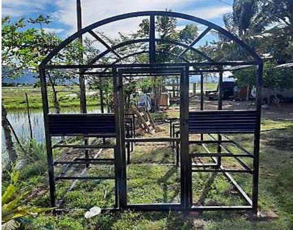
Gambar 1. Kerangka bangunan rumah pengering UV
