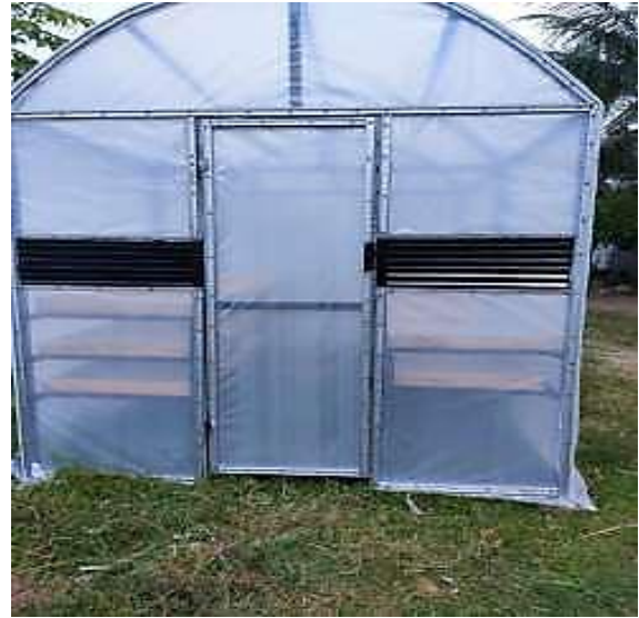
Gambar 3. Rumah pengering inovasi plastik UV yang sudah siap dibangun di lokasi pengabdian
