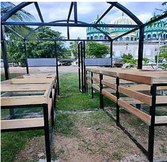
Gambar 2. Kerangka rak pengeringan rumah pengering UV
