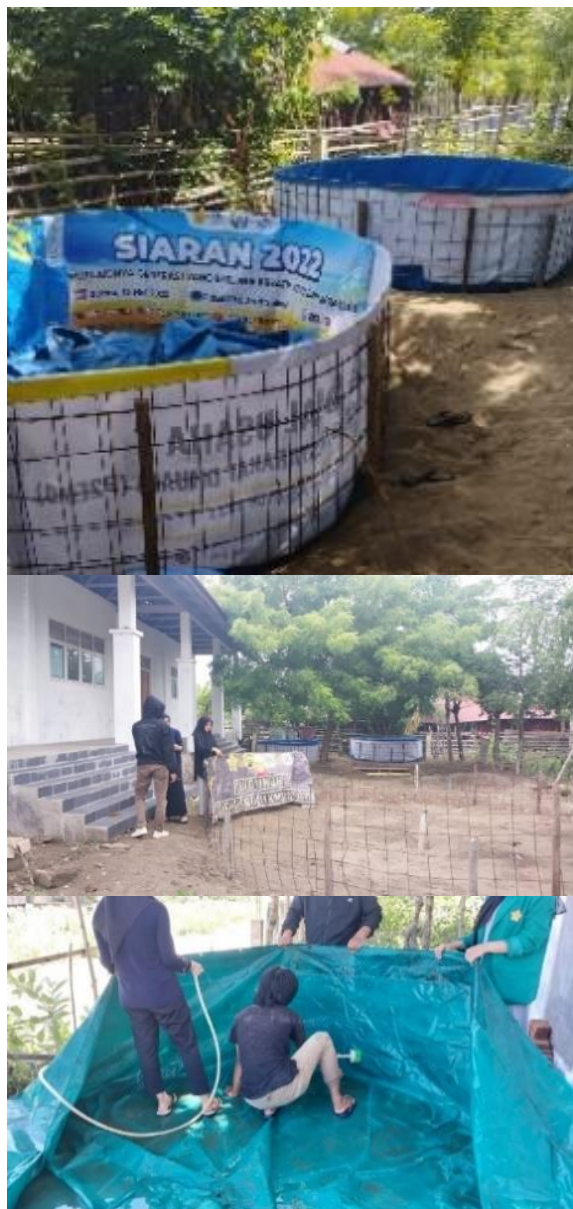
Gambar 5. Pemasangan terpal, wiremesh dan kolam bundar bioflok siap digunakan
