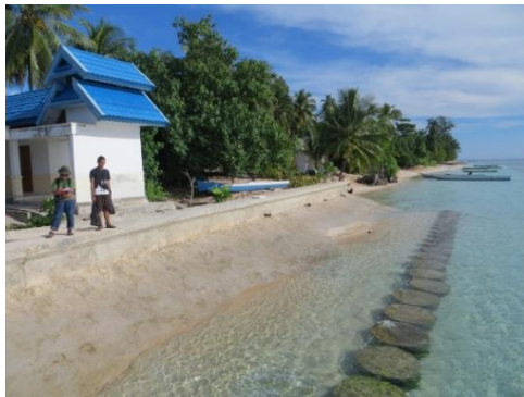
Gambar 5. Bangunan sea wall sepanjang 1 km dengan tinggi 75 cm di sekitar Desa Waha.
