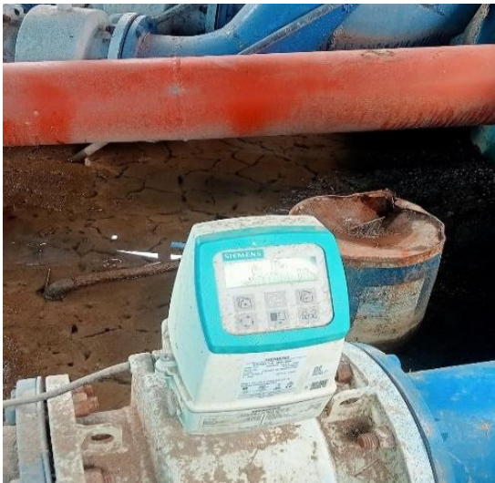
Gambar 10. Penerapan sensor Sitrans FM Mag 5000 di WTP PDAM Tirta Daroy
