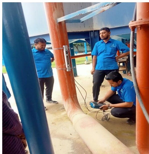
Gambar 13. Pengukuran debit air pada pipa distribusi dengan sensor OPTISONIC 6300 P
