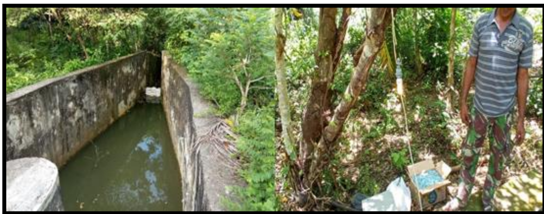
Gambar 1. Lokasi Pemasangan PLTMH di bendungan air saluran irigasi di Desa Gurah, Aceh Besar.
