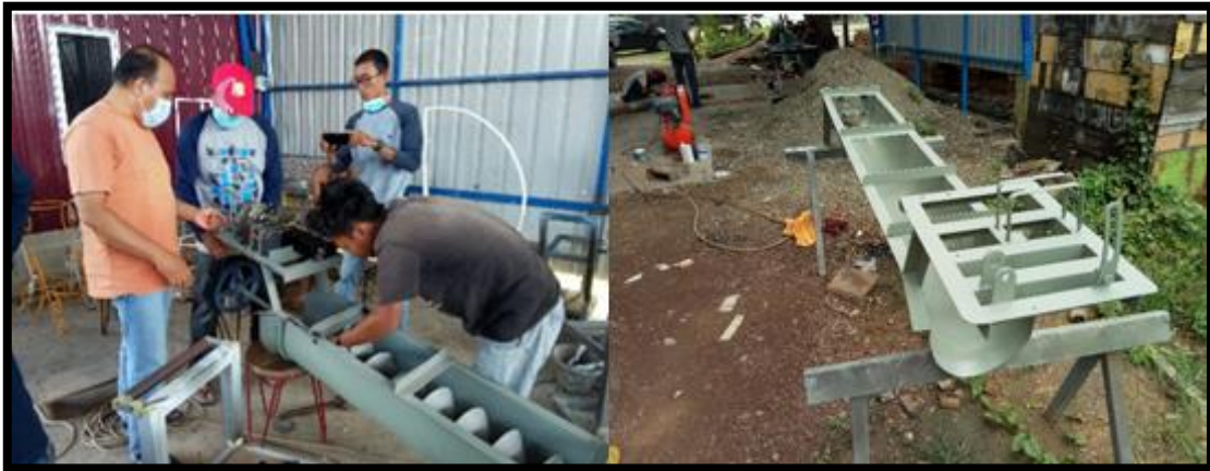
Gambar 3. Proses penyambungan bagian-bagian kerangka dan pemasangan bilah-bilah pada kerangka turbin ulir
