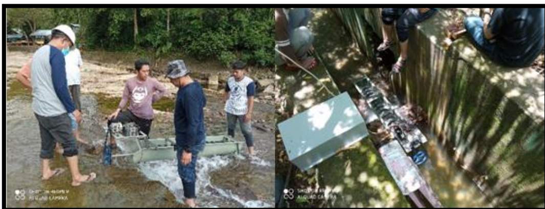
Gambar 6. Proses uji coba perangkat turbin ulir PLTMH di bendungan saluran irigasi Desa Gurah Kabupaten Aceh Besar
