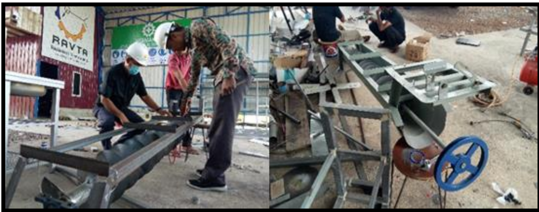
Gambar 2. Proses pembuatan kerangka turbin ulir sebagai penggerak utama dalam pembangkit listrik tenaga air
