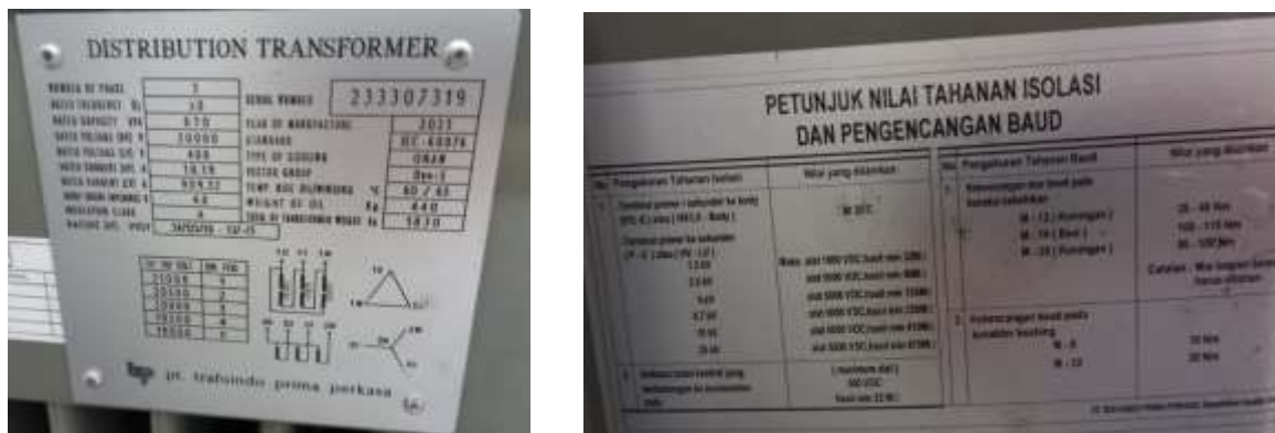
Gambar 1. Spesifikasi dan standar pemasangan transformator
