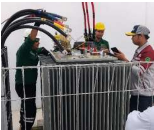
Gambar 5. Pengecekan instalasi pengkabelan pada transformator
