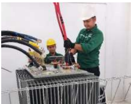
Gambar 6. Pemasangan kabel dan pengecekan panel utama
