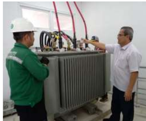
Gambar 5. Pengecekan instalasi pengkabelan pada transformator
