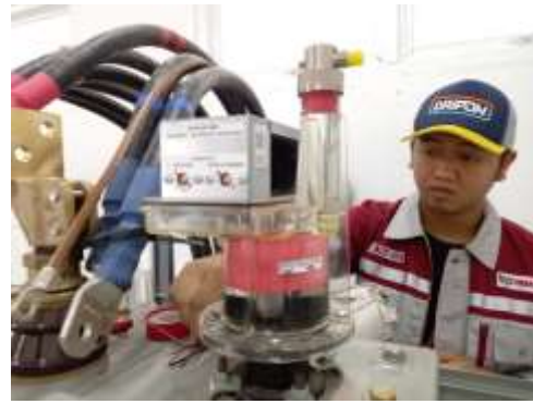
Gambar 4. Pengecekan kondisi fisik dan sistem pengamanan pada transformator
