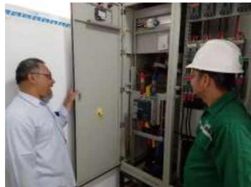
Gambar 6. Pemasangan kabel dan pengecekan panel utama
