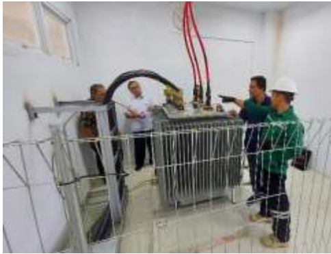
Gambar 4. Pengecekan kondisi fisik dan sistem pengamanan pada transformator
