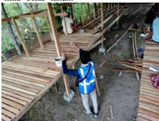
Gambar 1. Proses pembuatan kandang kambing perah
