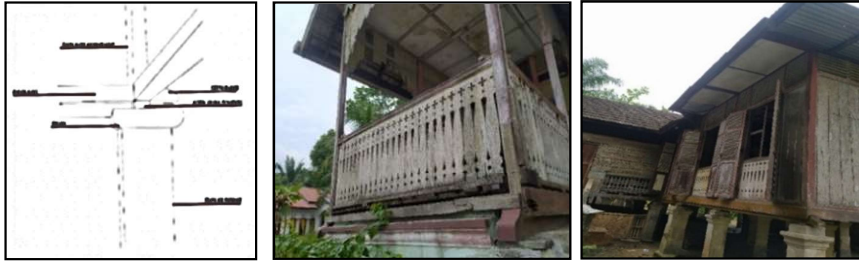
Gambar 3.10 Sambungan Pada Rumah Datuk Padang Tualang Sumber: dokumen pribadi (2020)
