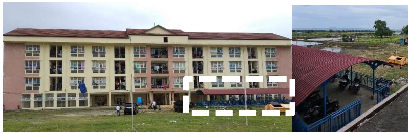
Gambar 12. Fasilitas Parkir Rusunawa Lampulo Sumber : BP2P Wilayah I, Penulis, 2022
