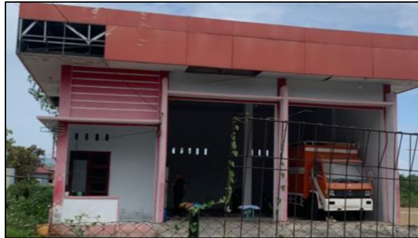
Gambar 3.2. Kondisi pos pemadam Sumber: Penulis, 2022
