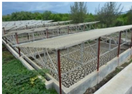
Gambar 19. Pengelolaan limbah Tinja menjadi Pupuk di IPLT Kota Banda Aceh
