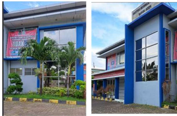
Gambar 10. Jendela dan Pintu Masuk (Sumber: Dok. Penulis, 2023)
