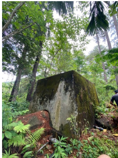
Gambar 10. Bak penyimpan/pembagian Sumber : Penulis (2022)
